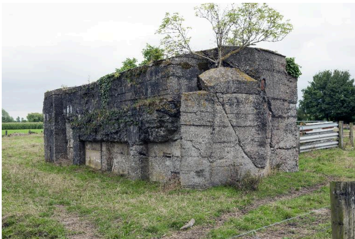
Vue latérale, vers le sud-est
