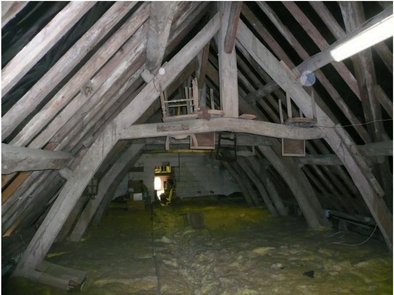
Vue de la charpente du logis.
