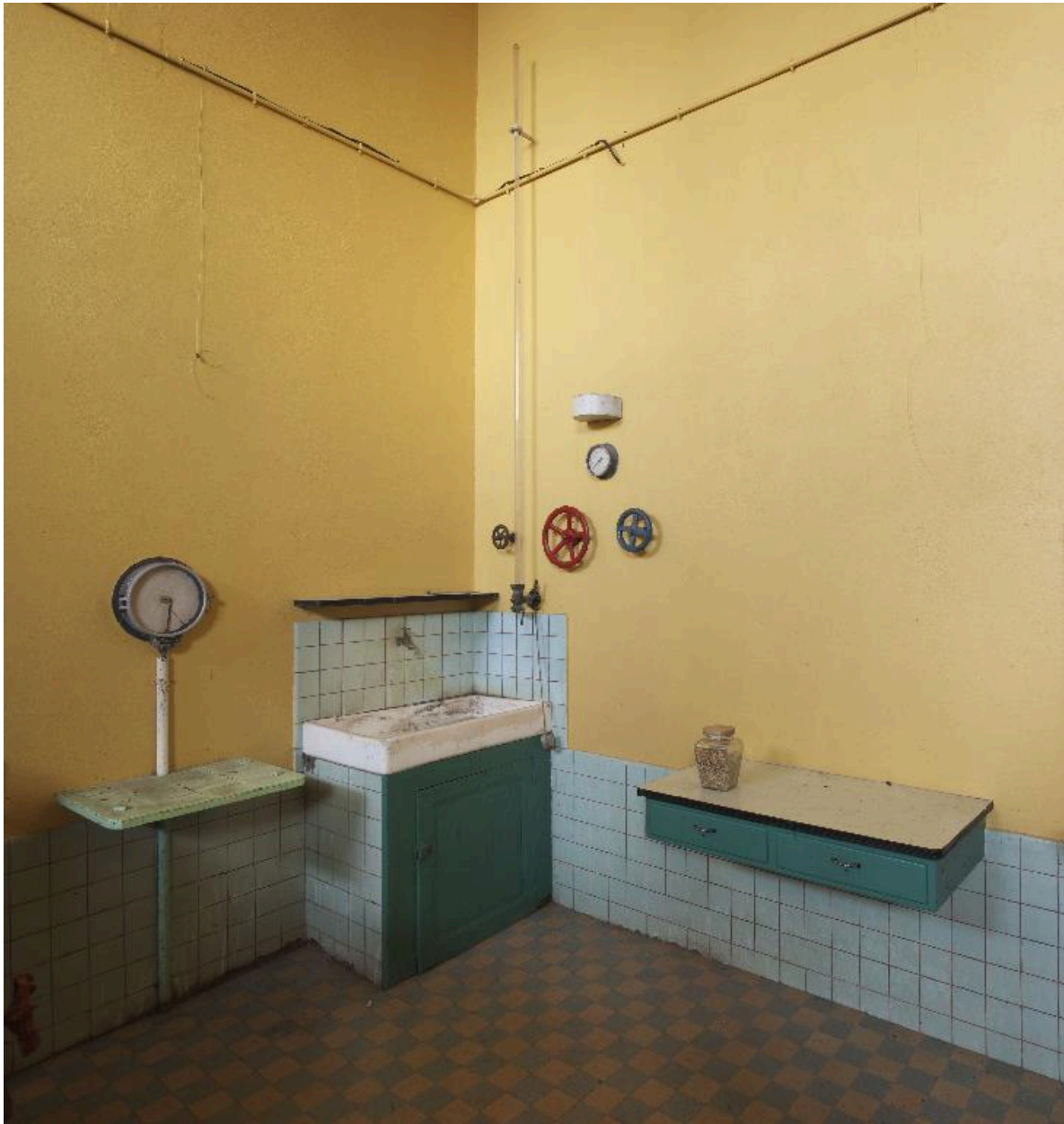
Salle de brassage, détail de l'enceinte de nettoyage des instruments d'échantillonnage.
