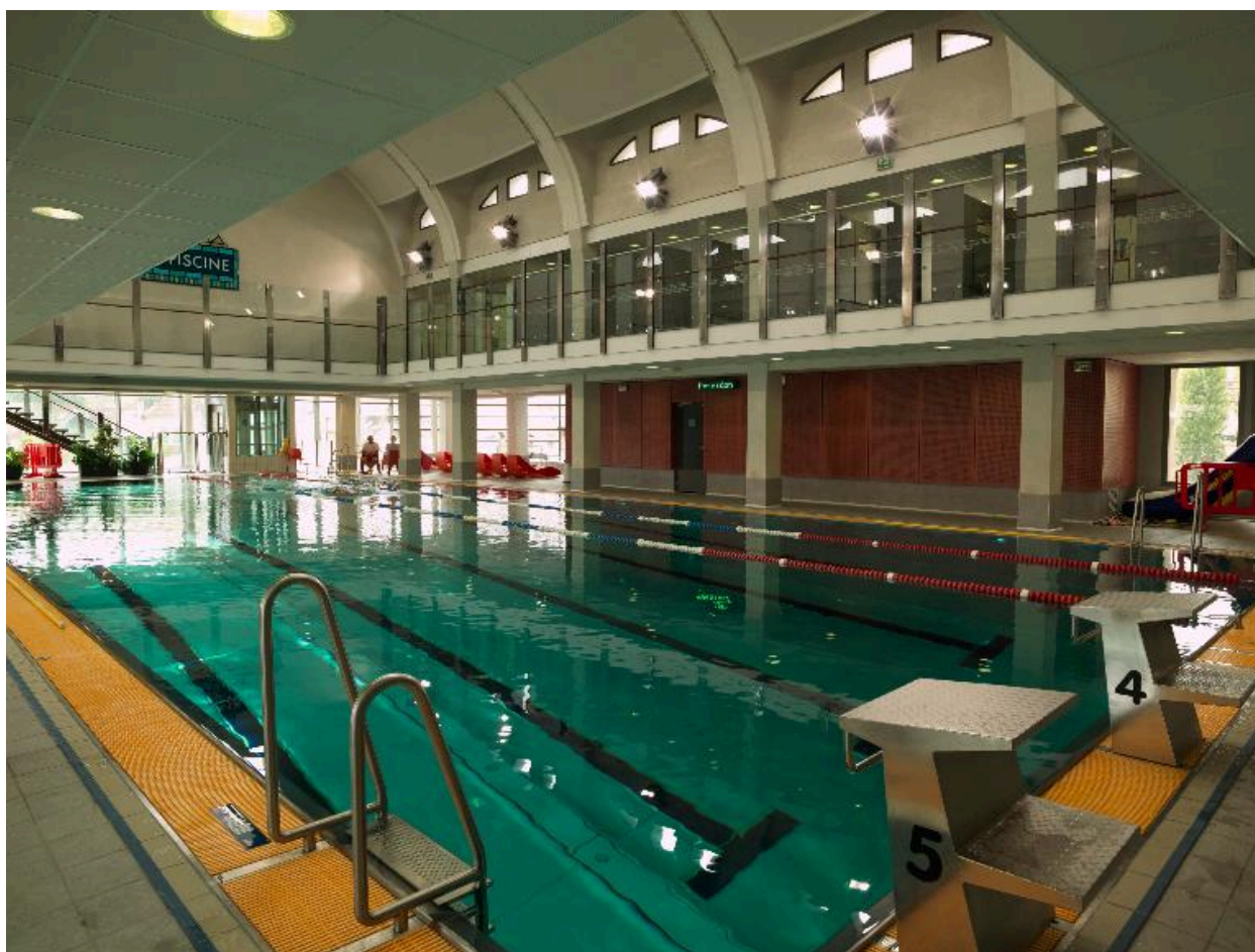
Vue générale du bassin sportif, détail des tremplins. A l'étage, se trouvent les vestiaires.
