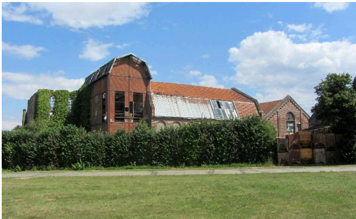
Vue d'ensemble sud de la râperie.
