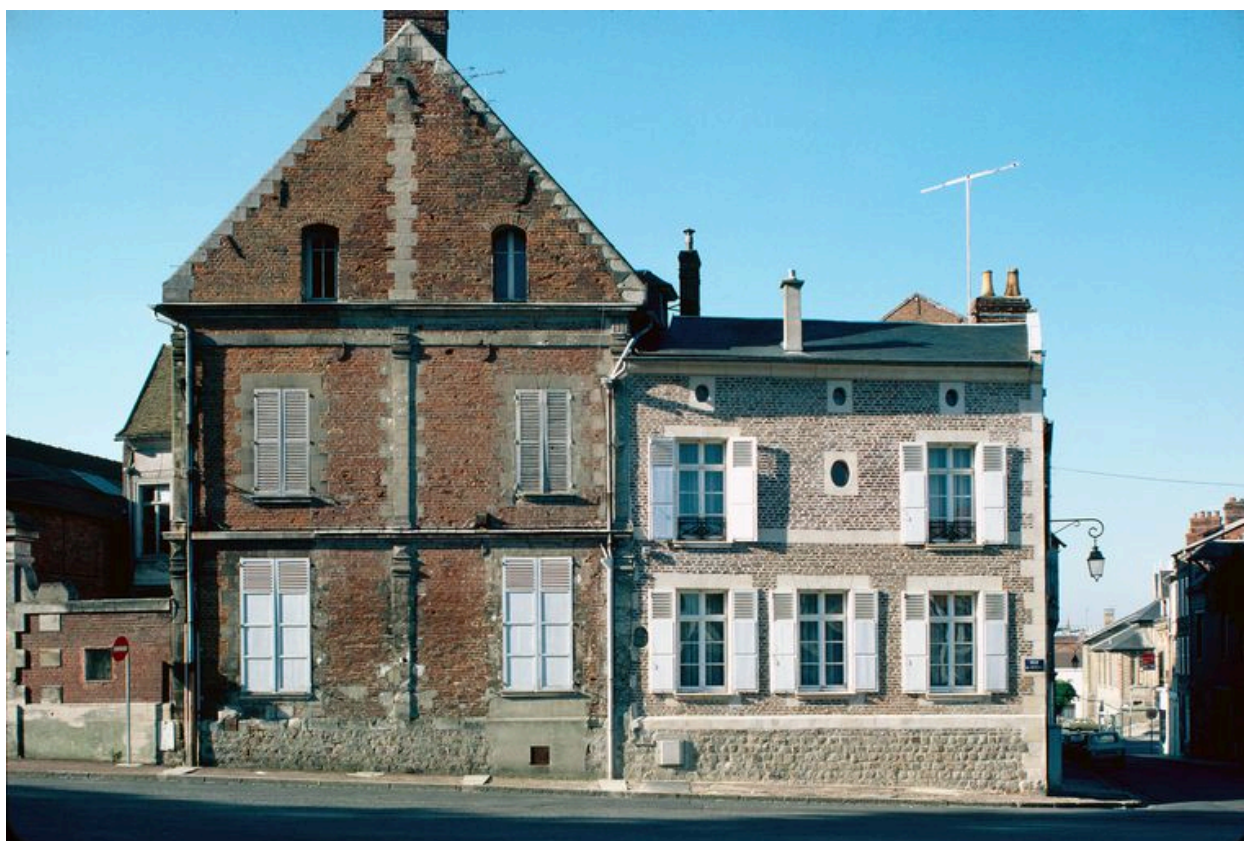
Elévation antérieure. Pignon.
