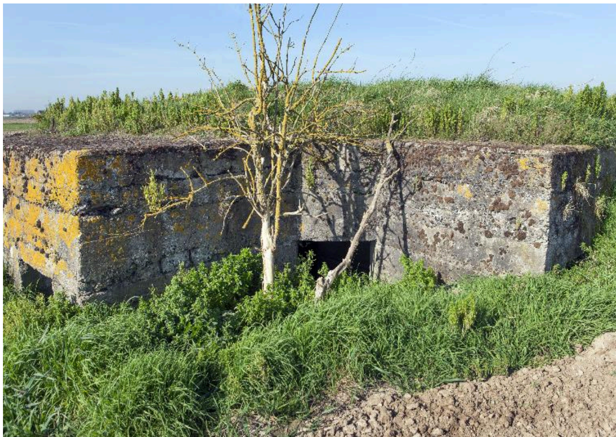
Entrées est et sud-est
