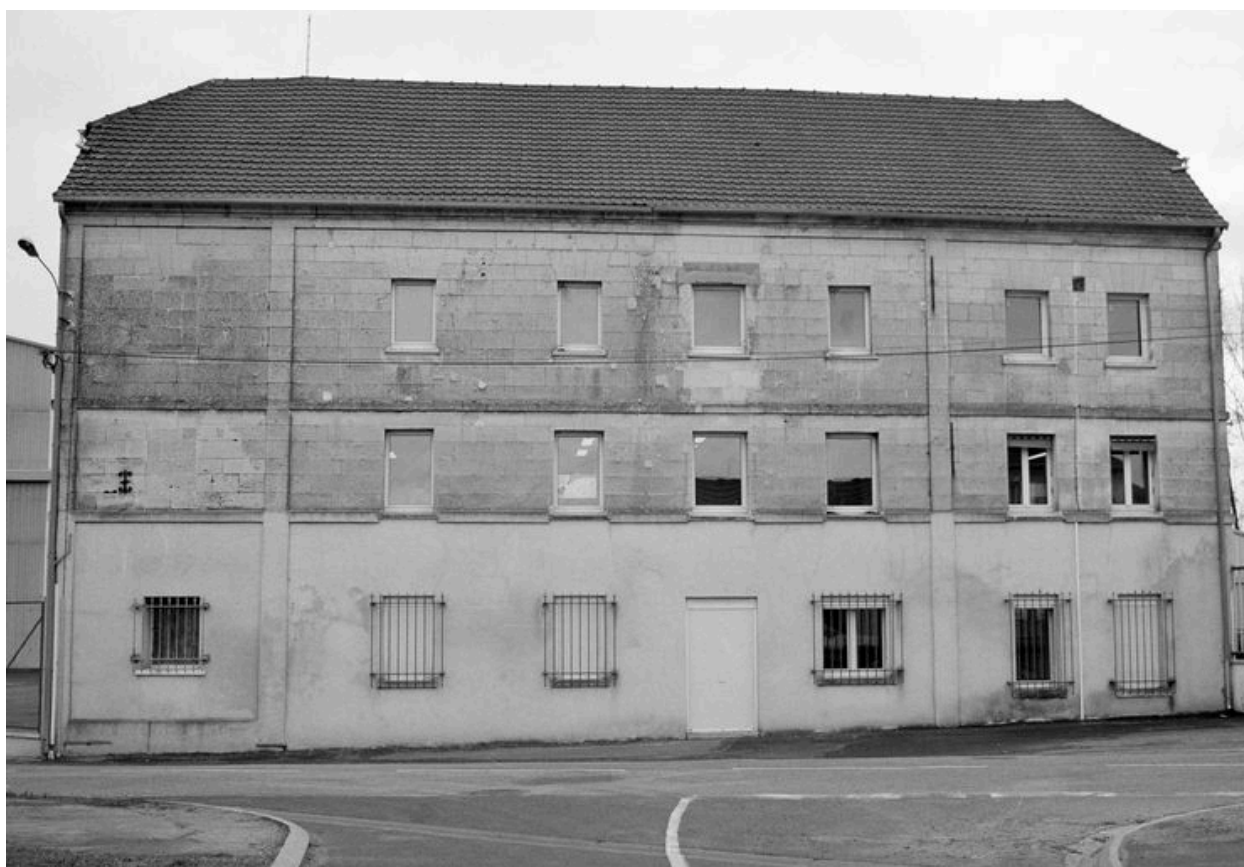
L'ancien moulin à blé : façade sur rue.
