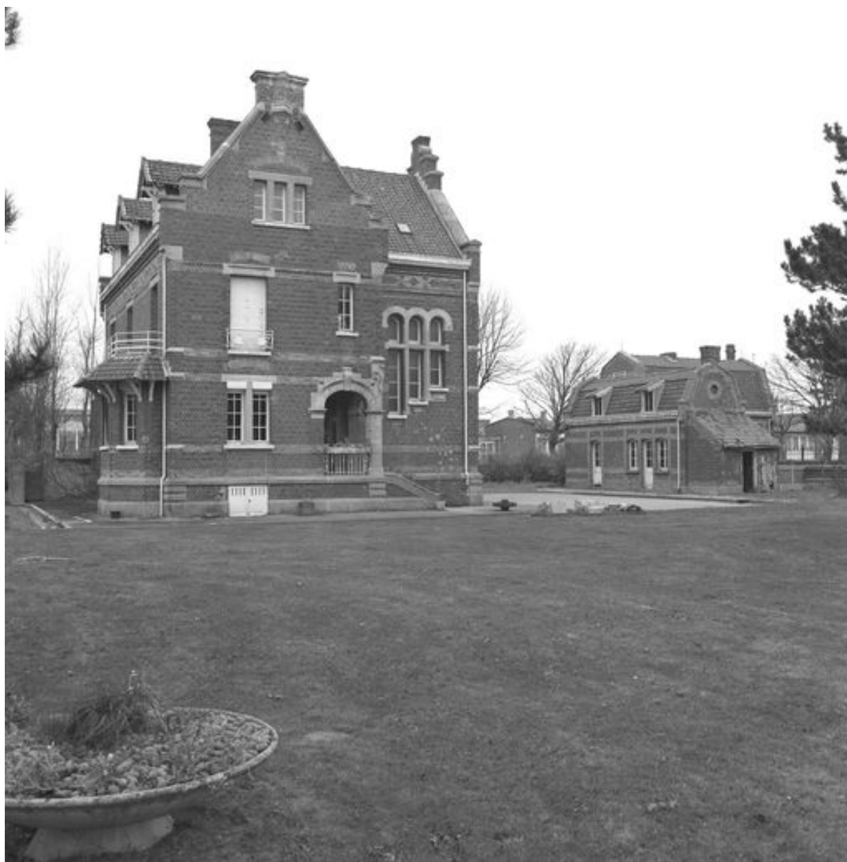
Habitation du directeur, élévation latérale droite, vue générale prise de trois quarts gauche.
