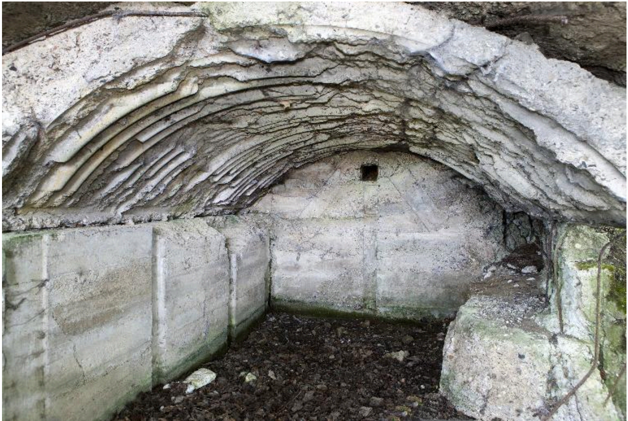
Casemate n°1, Vue interieure
