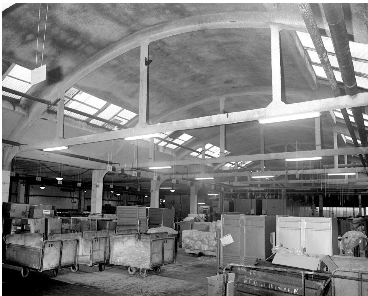
Atelier de fabrication. Vue intérieure.
