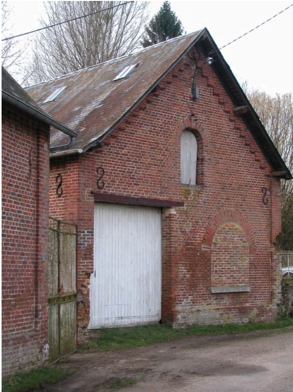
Pignon sur rue de l'atelier de fabrication.
