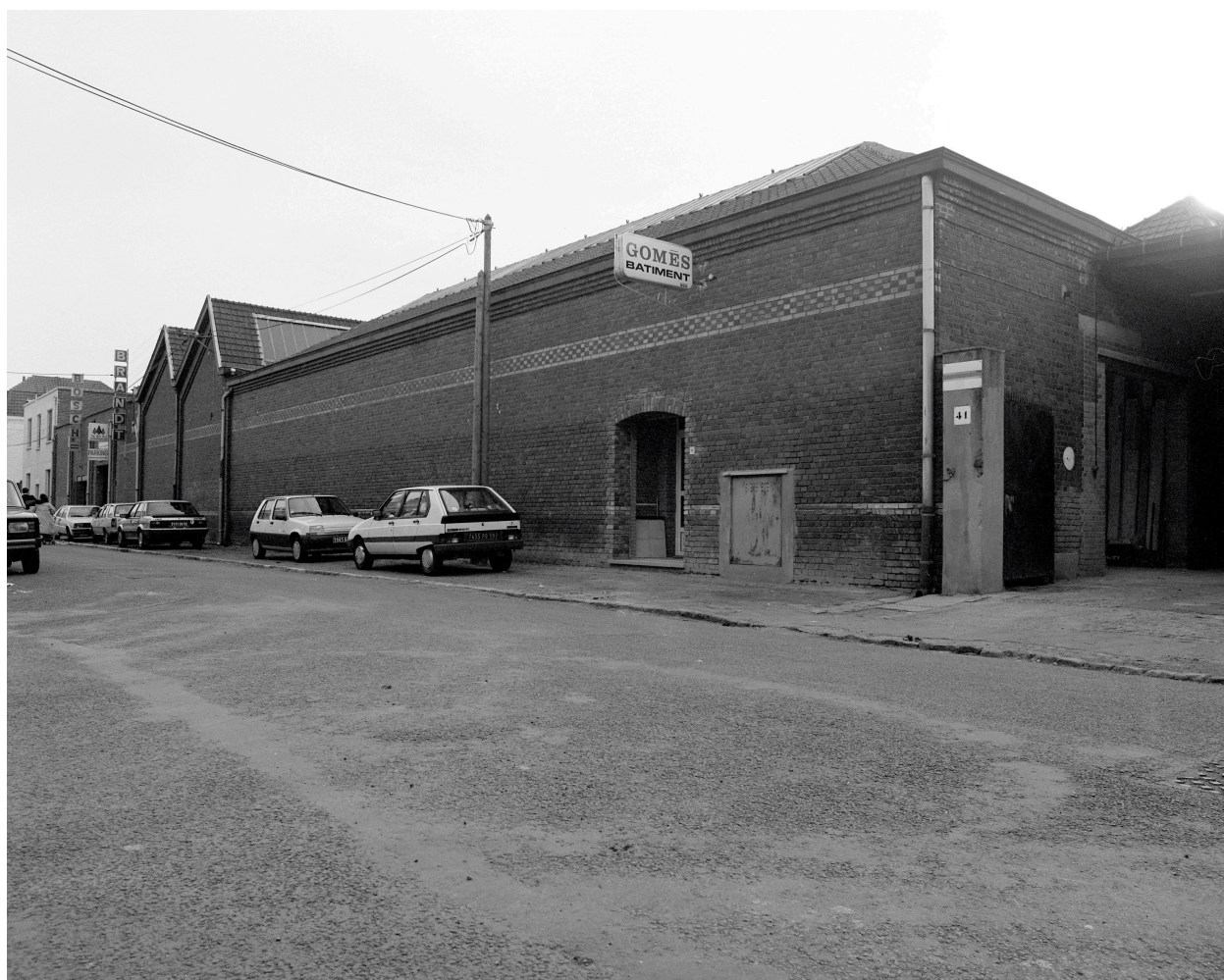
Élévation rue Voltaire, vers le sud.
