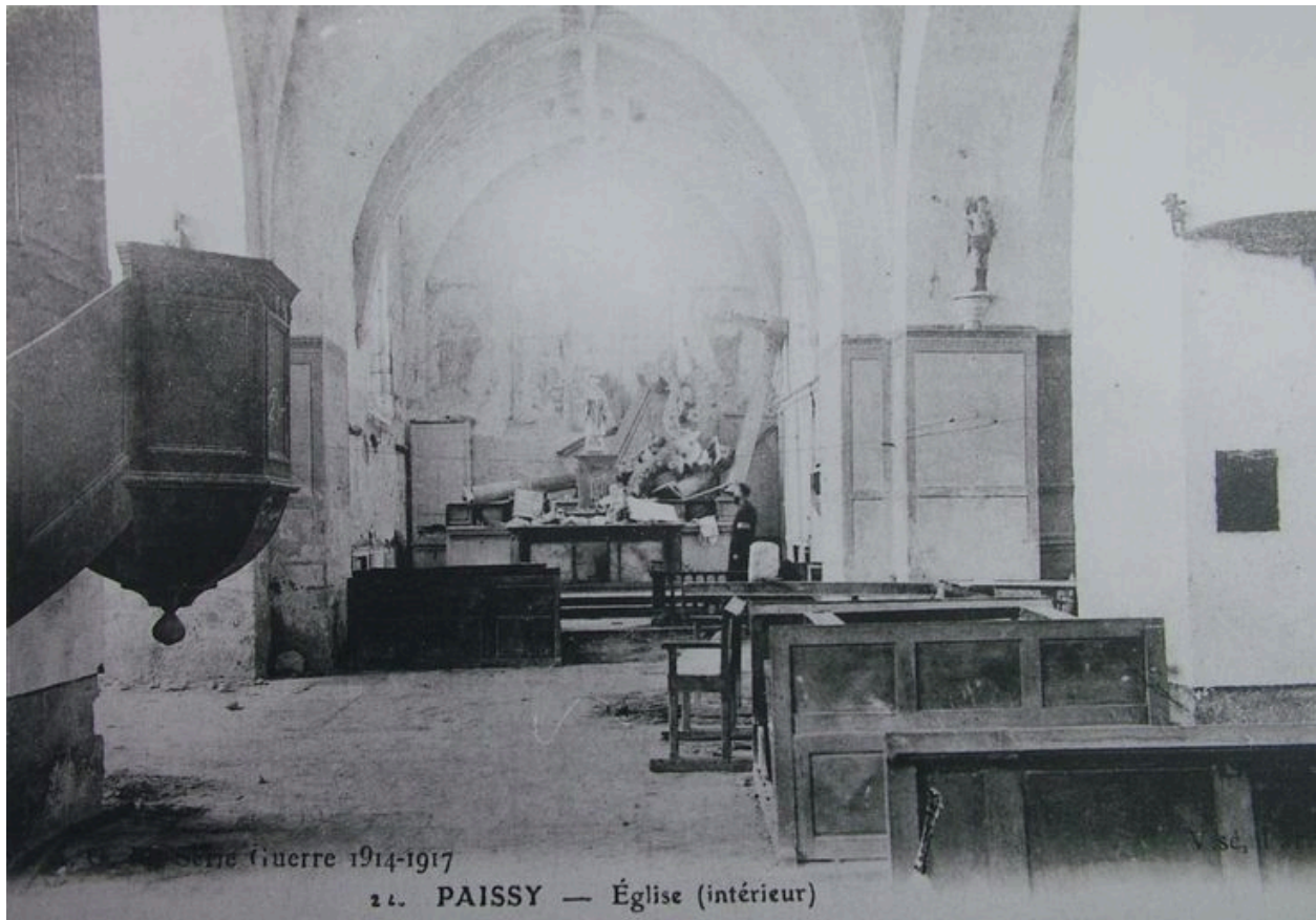
Vue intérieure de l'église en ruines (coll. part).
