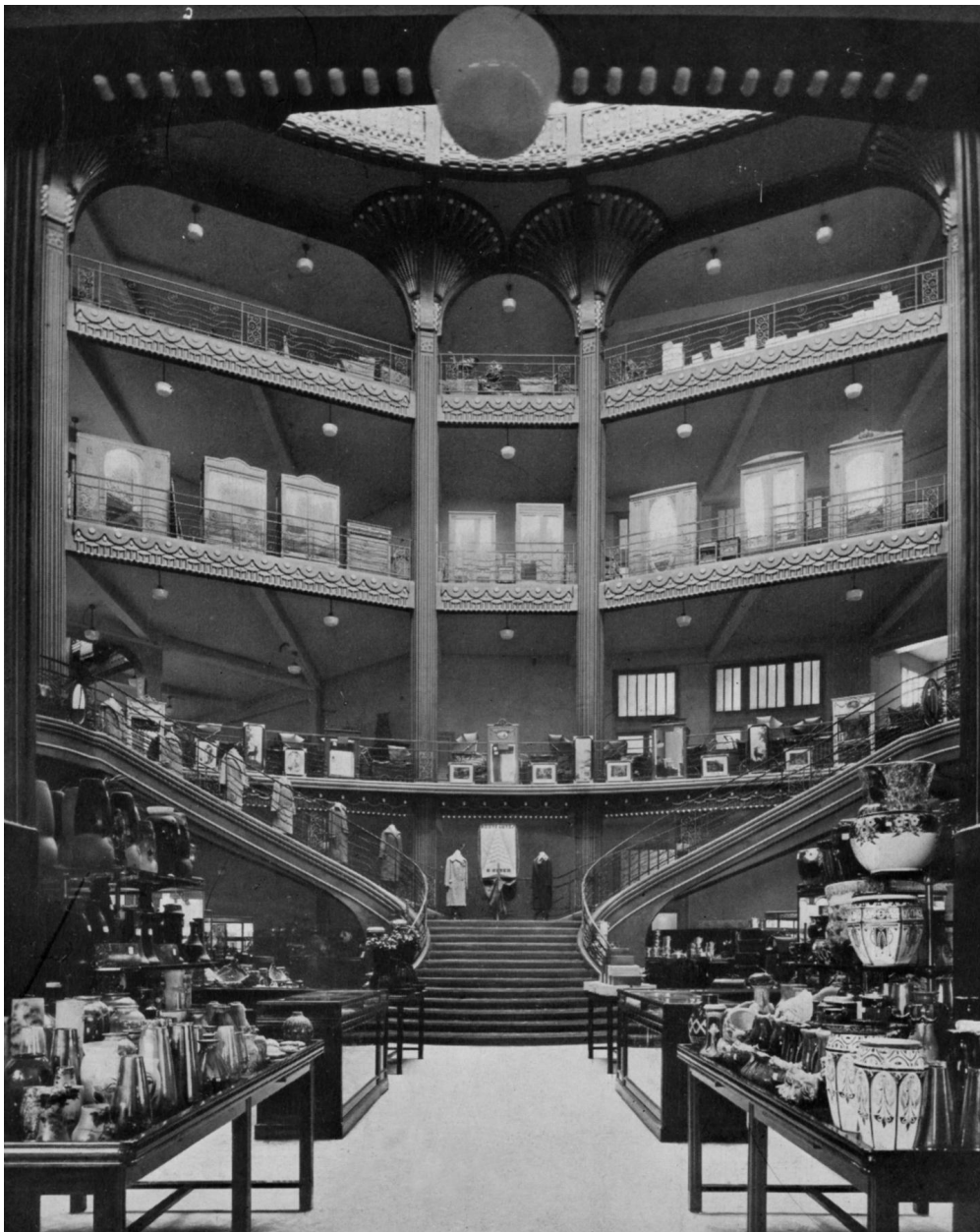
Vue de l'atrium ovale et du grand escalier entre 1927 et 1934 (Cité de l'Architecture et du Patrimoine ; fonds des Bétons armés Hennebique ; 3-D-364-i).
