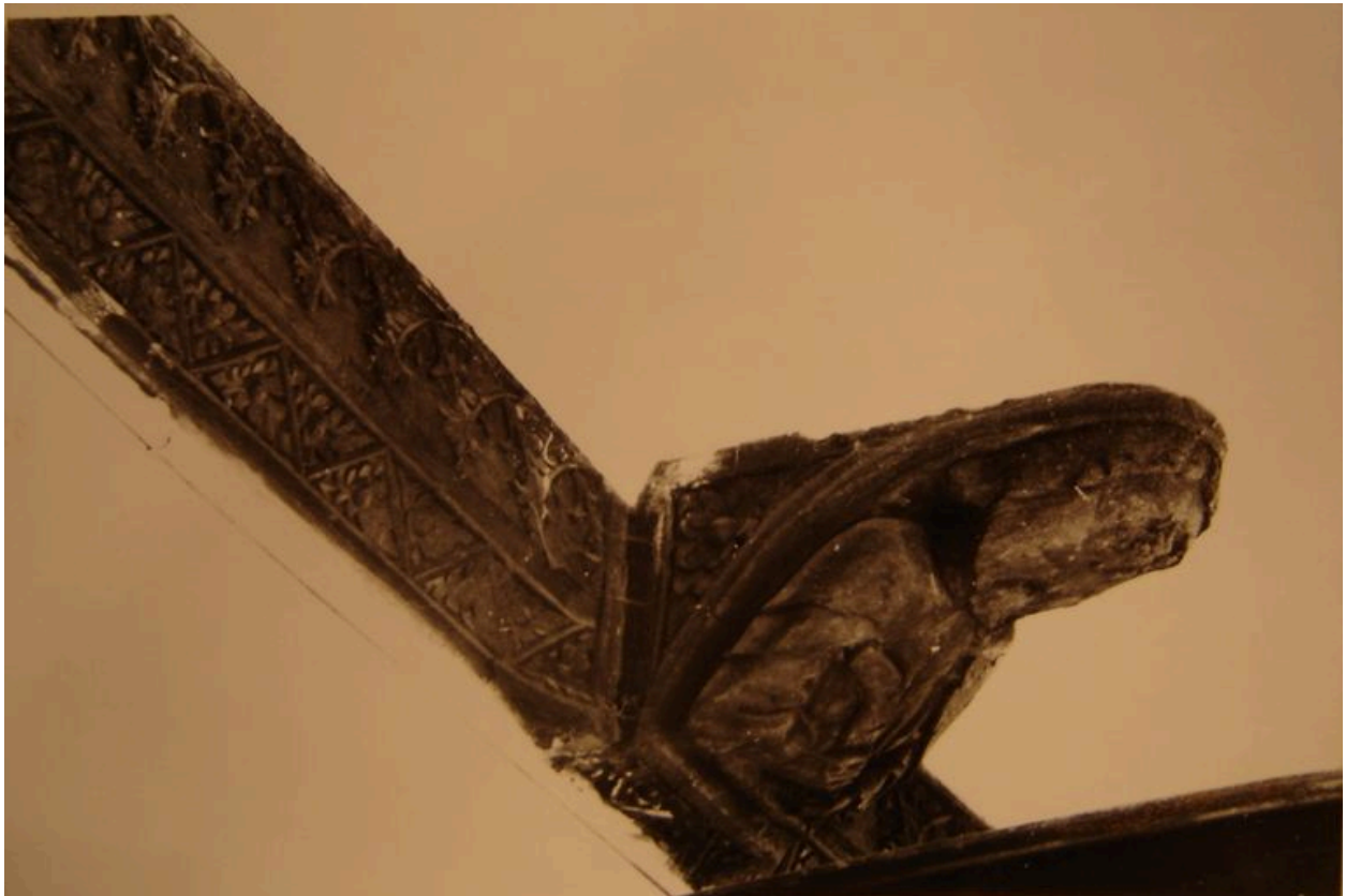
Vue détaillée d'un blochet bûché.
