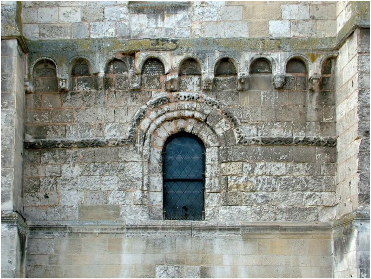
Détail de l'élévation sud du clocher, deuxième niveau.
