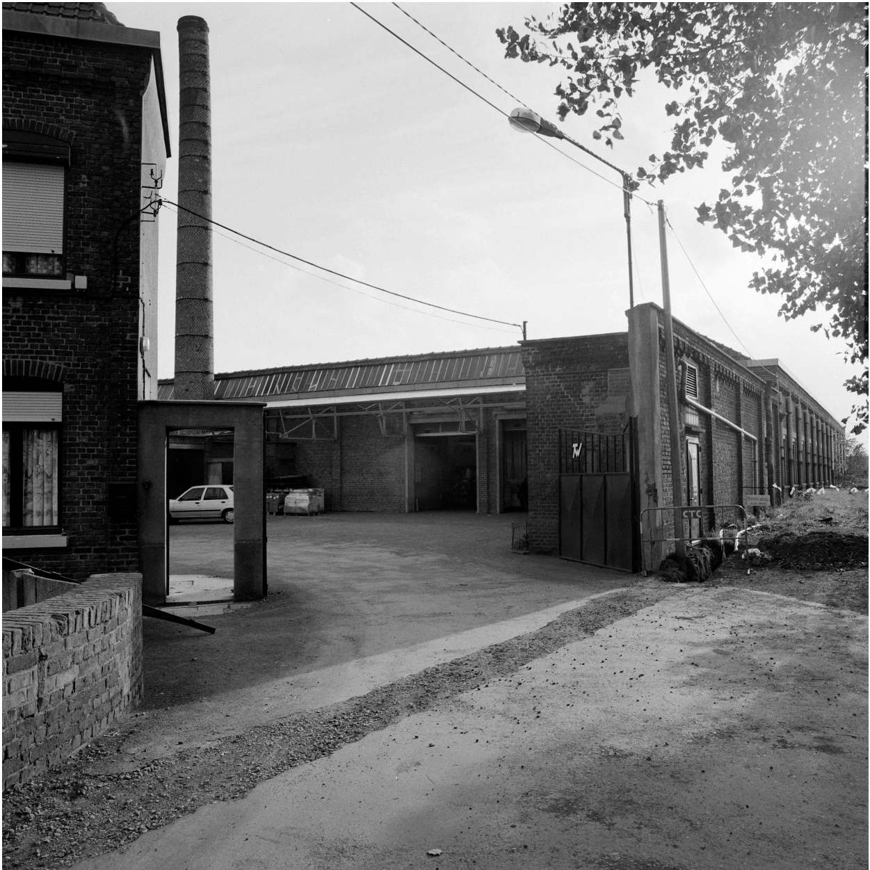
Entrée, élévation ouest.
