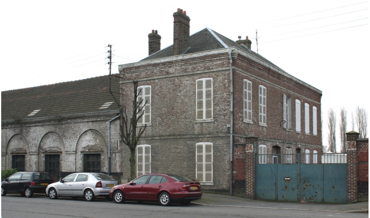
Bureaux, logement (?) et atelier, 24 boulevard Victor-Hugo.
