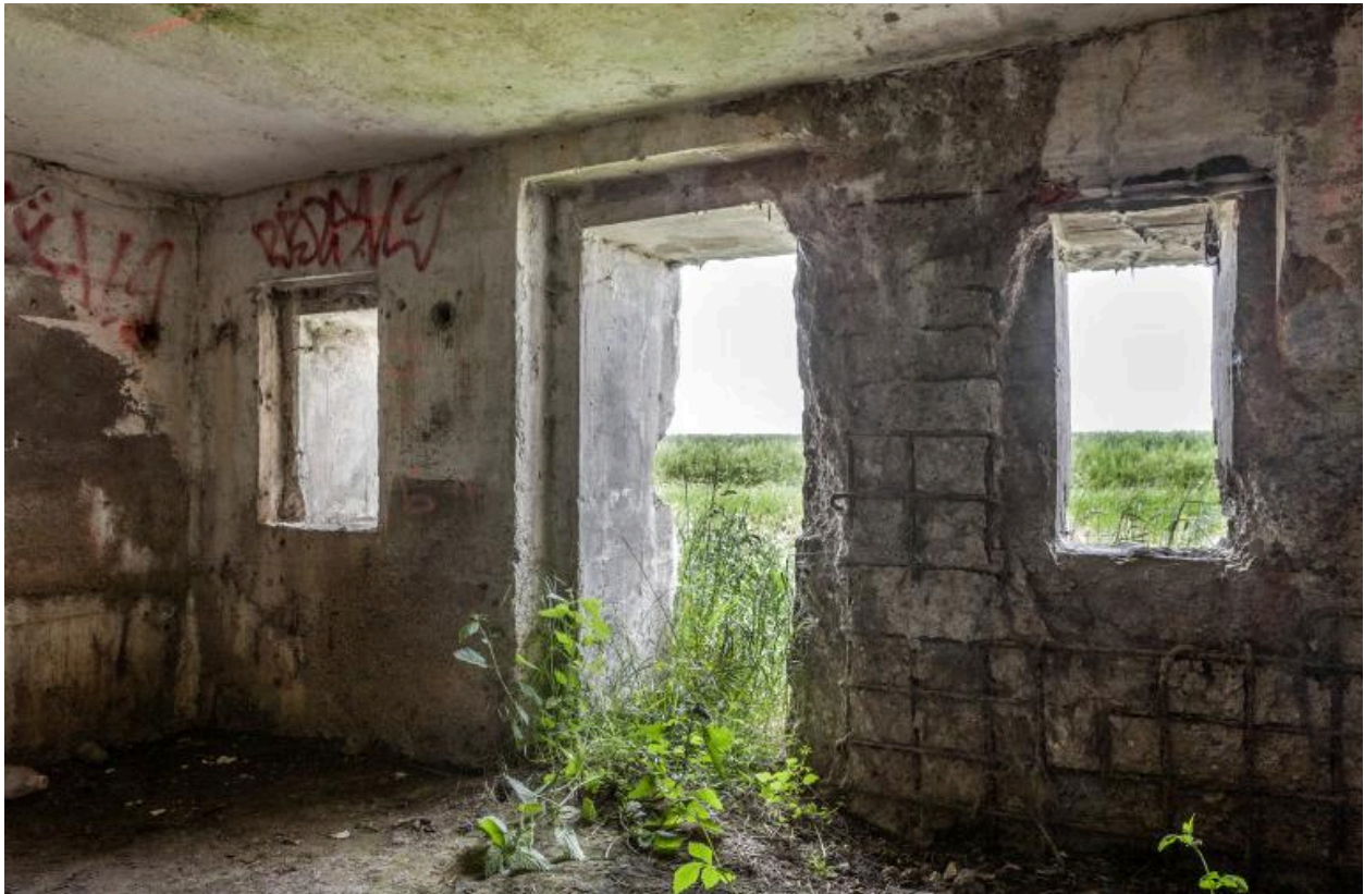
Vue de la première salle (au sud) vers l'extérieur.
