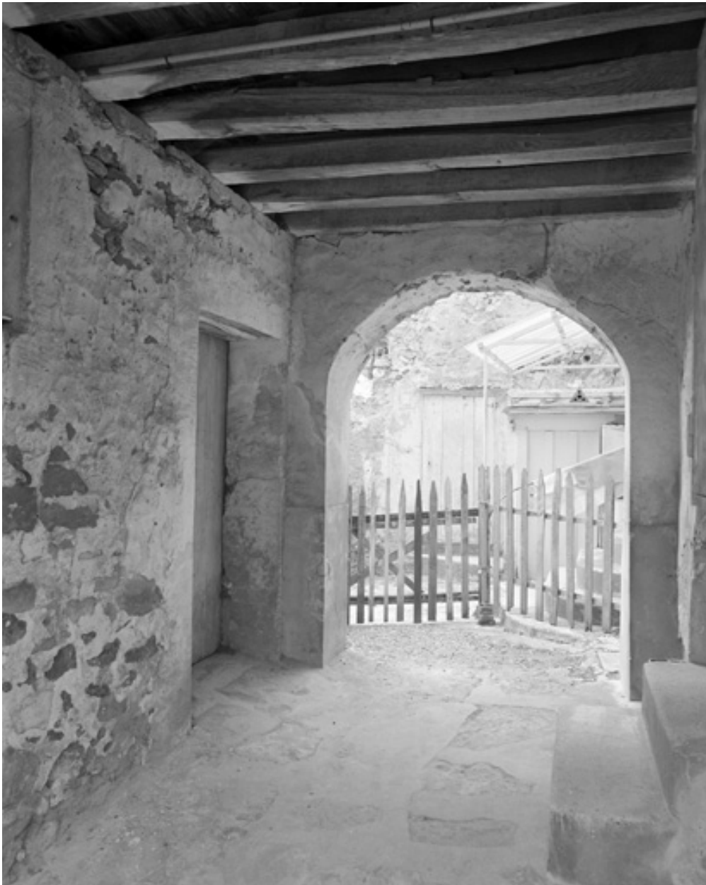
Vue du passage sous le bâtiment principal.
