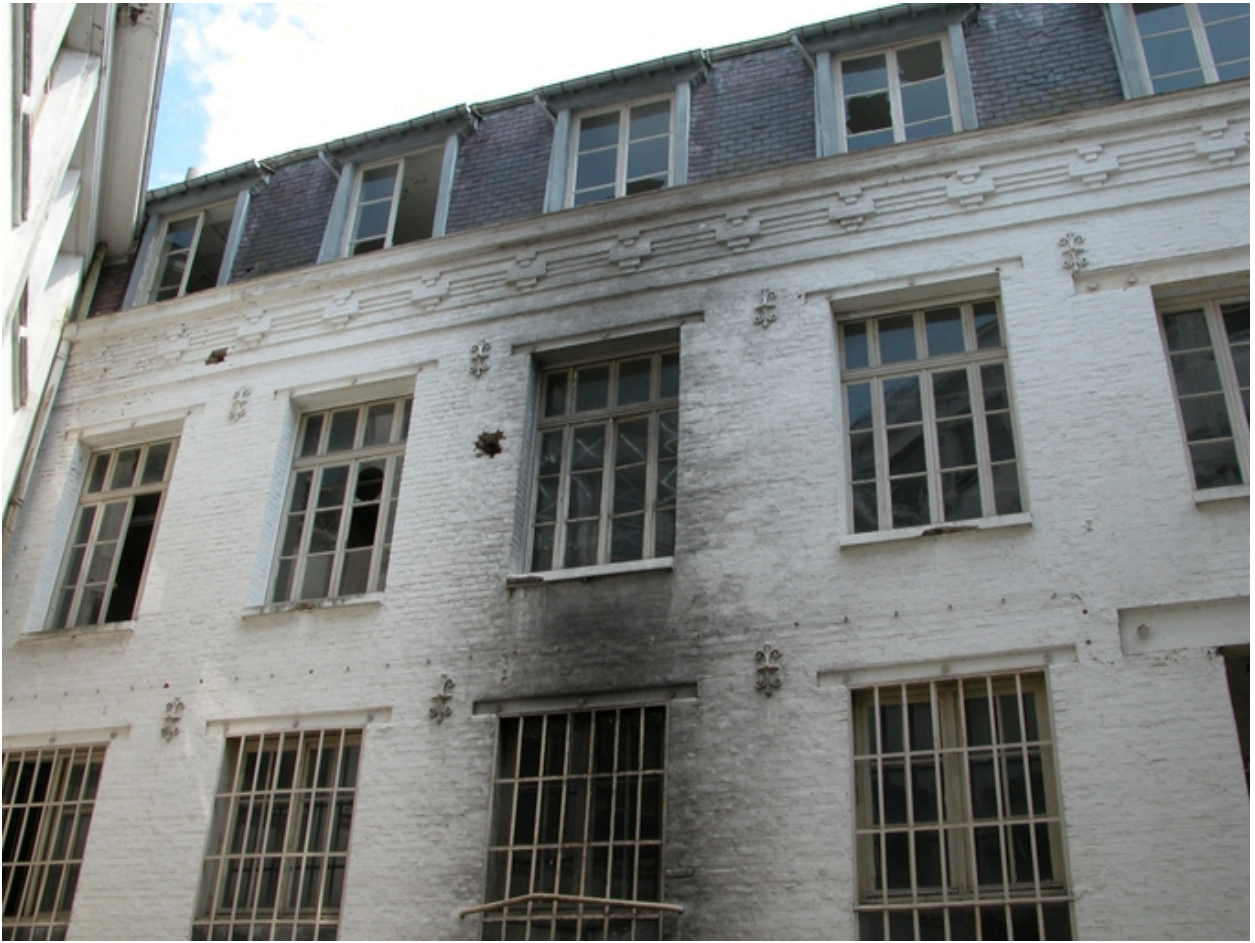
Anciens ateliers de préparation, piquage, broderie, et magasin à guipure : façade ouest.
