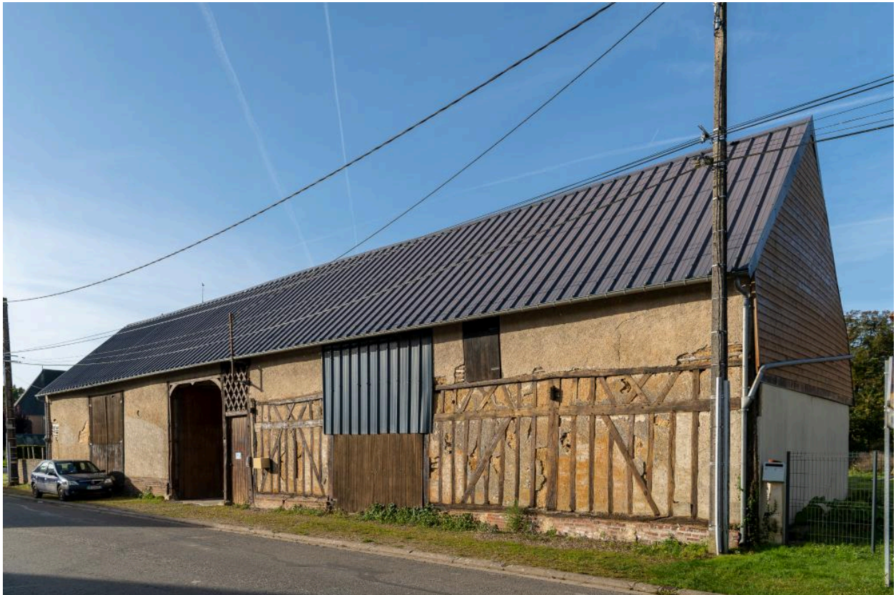
Grange, étable et passage charretier, n°51 rue Principale, vue depuis l'est.
