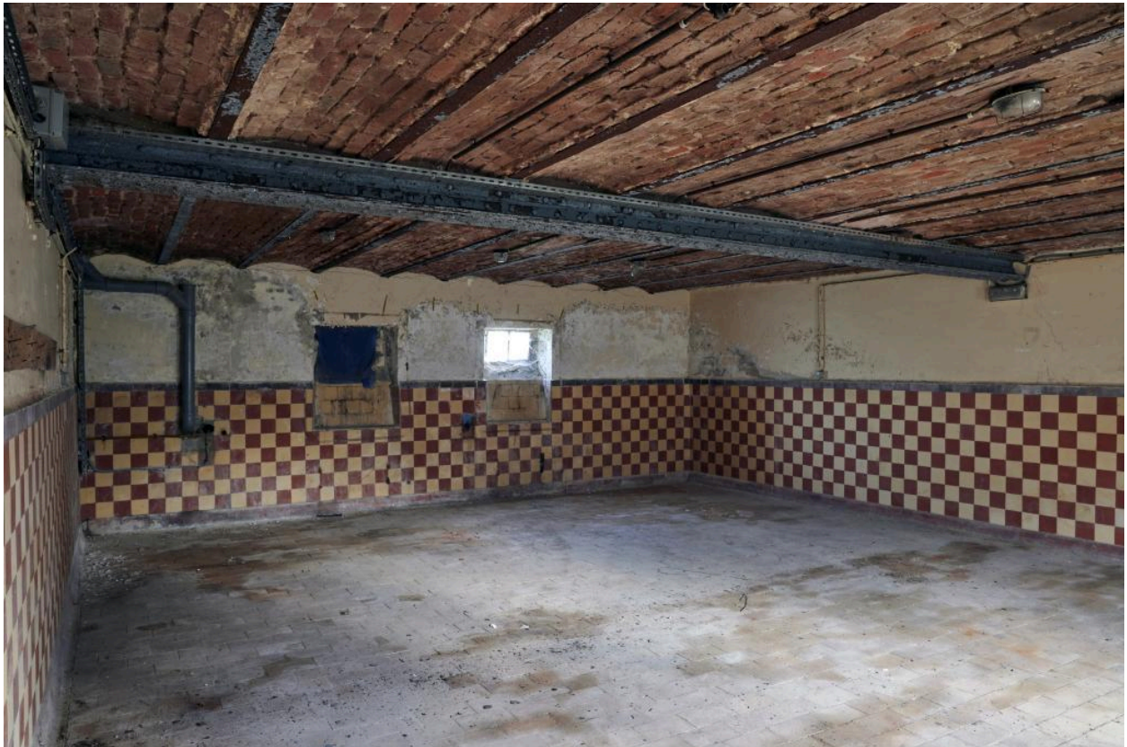
Sous-sol du logement du chef d'élevage.
