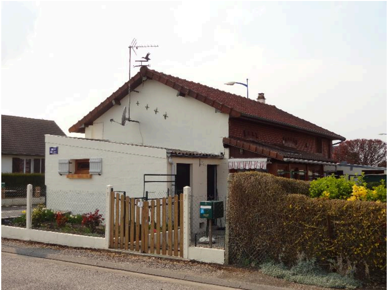
Vue générale de la gare depuis la Ruelle Goutte.
