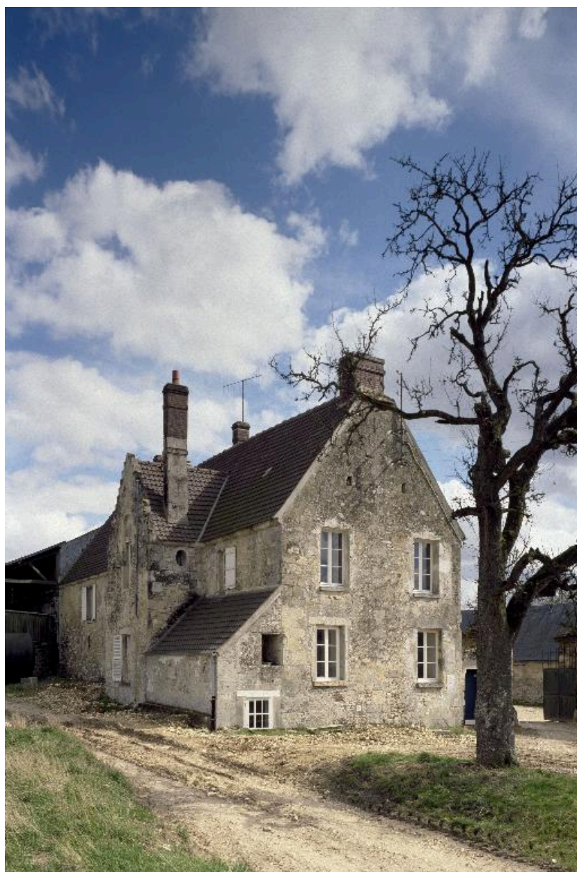
Vue générale du logis, depuis le nord-ouest.
