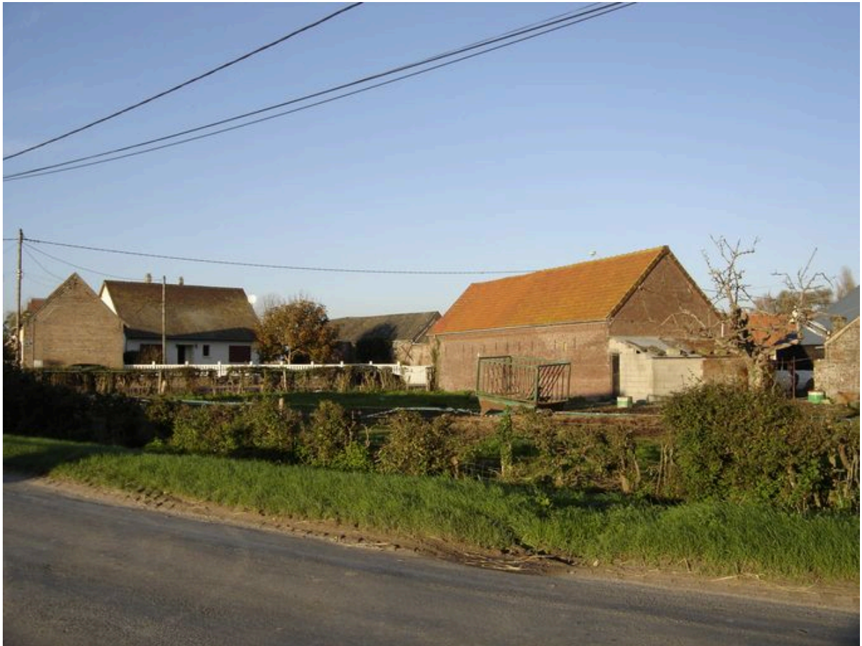
Vue générale postérieure depuis la route de Lanchères.
