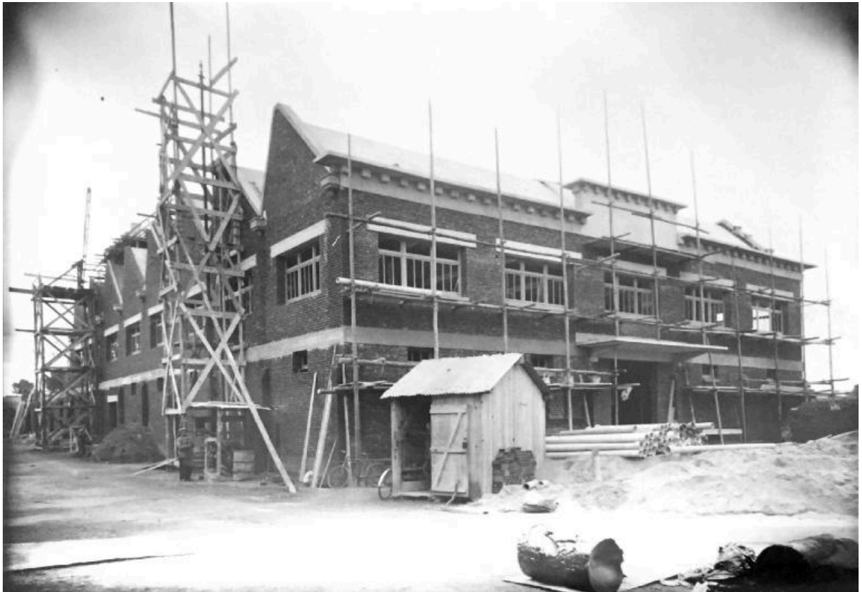
L'entrepôt des matières premières et l'atelier de confection en cours de construction, printemps 1946 (coll. part.).
