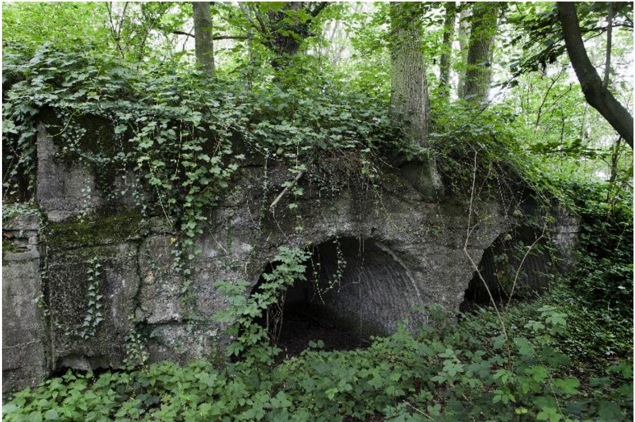
Casemate n°3, élévation antérieure, partie nord.
