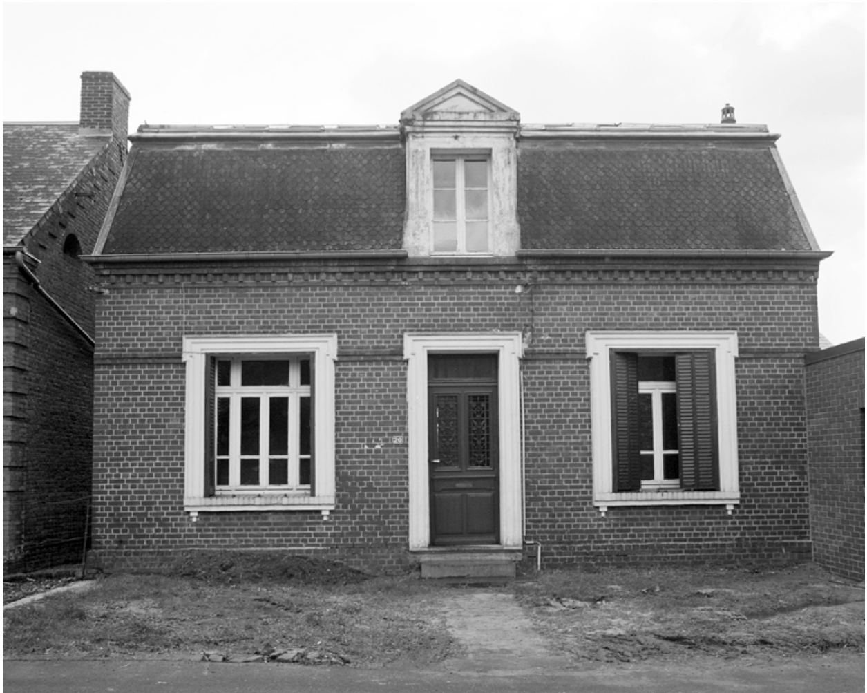
Vue générale de la façade.
