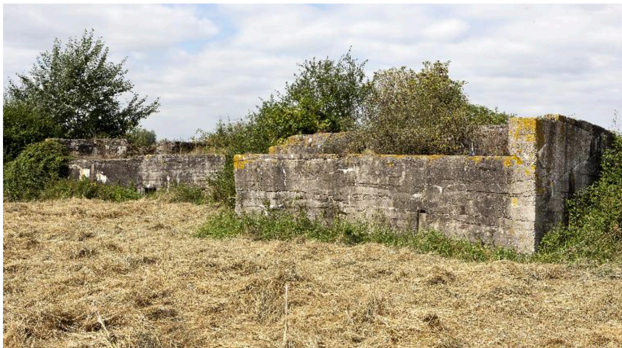
Casemate B, vers l'ouest, au premier plan. Dans le fond à gauche, la casemate A.
