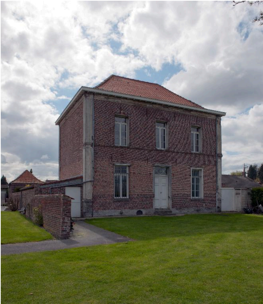
Elévation postérieure de la mairie, façade en brique non enduite et pilastres ioniques aux angles.
