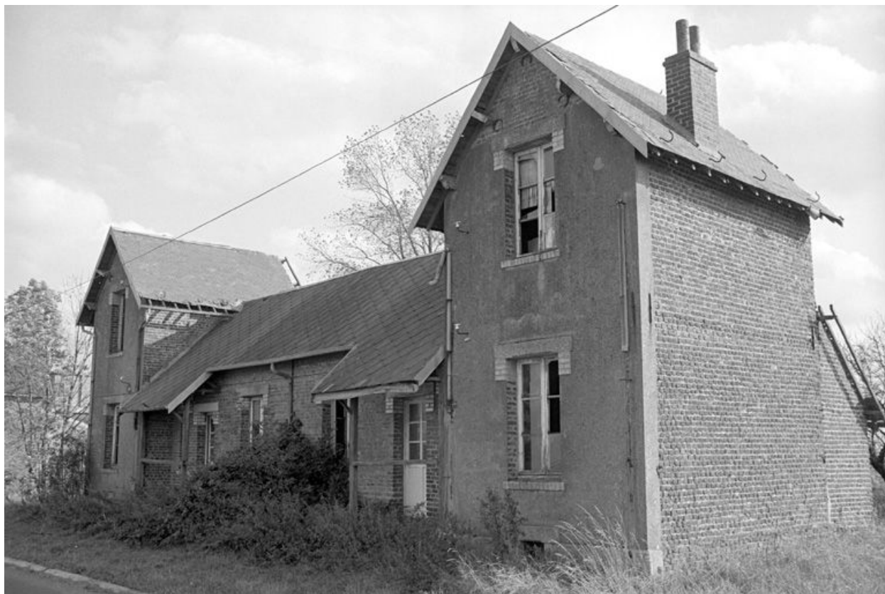
Logement d'ouvriers, vue générale, élévation antérieure.
