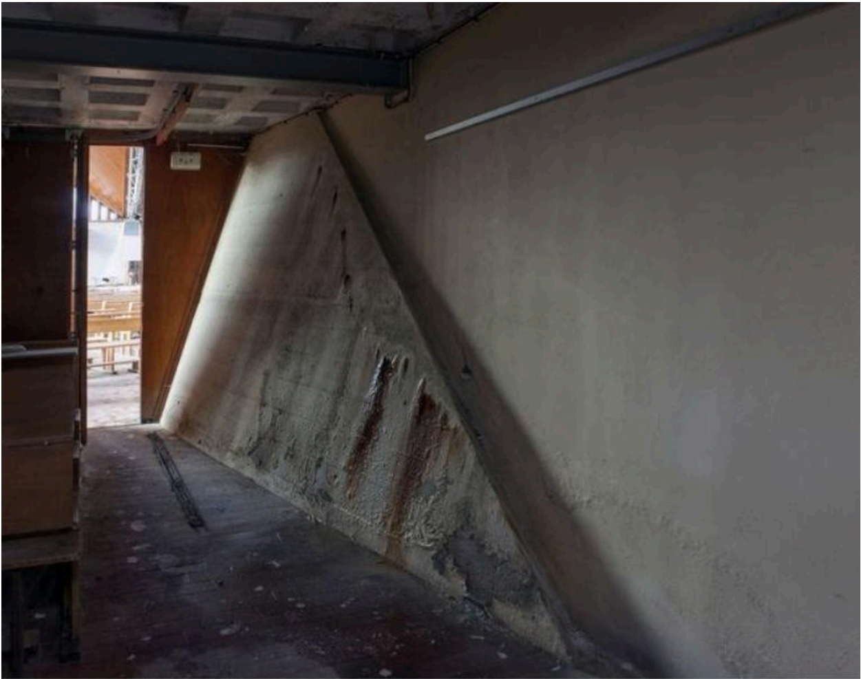
Mur d'une salle paroissiale.
