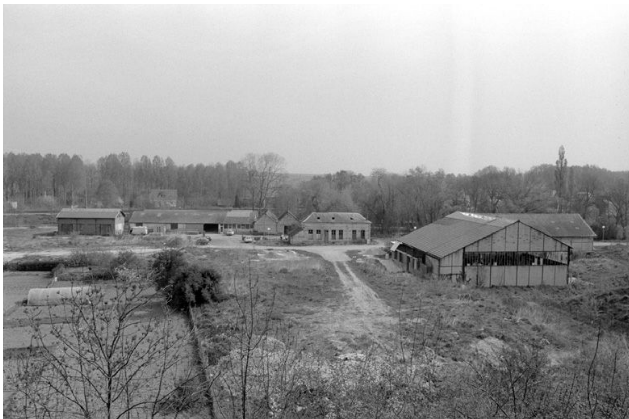
Vue générale de l'usine.
