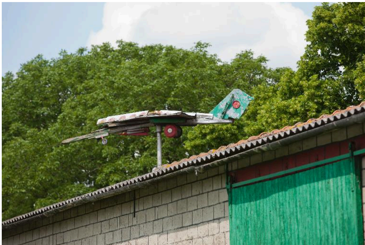
Avion sur le toit du bâtiment annexe de la grange.
