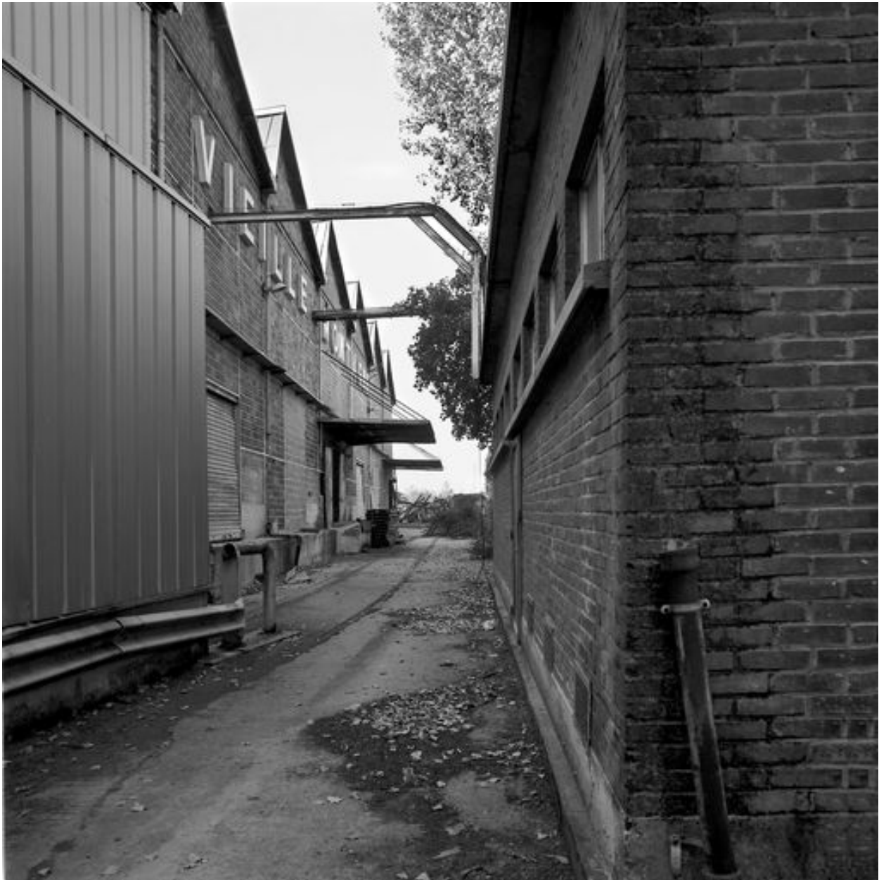
Quais de chargement et de déchargement.
