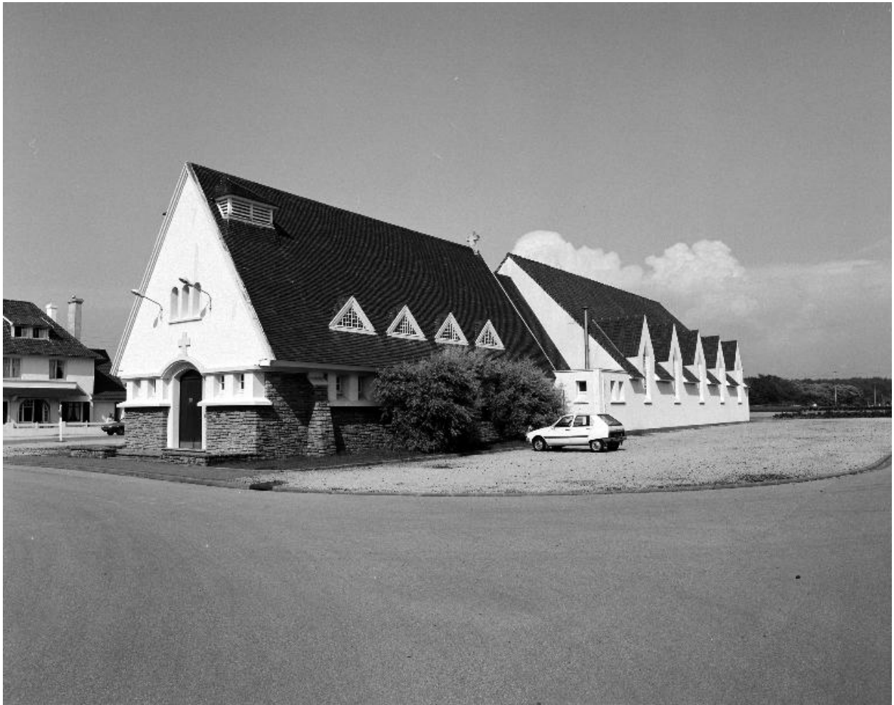
Vue d'angle sud-ouest.
