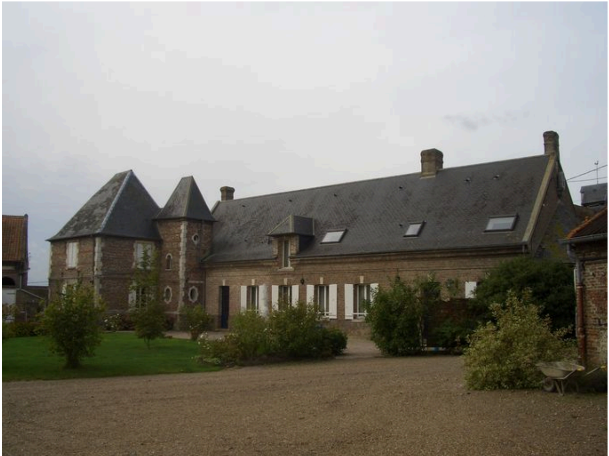
Vue postérieure du logis.
