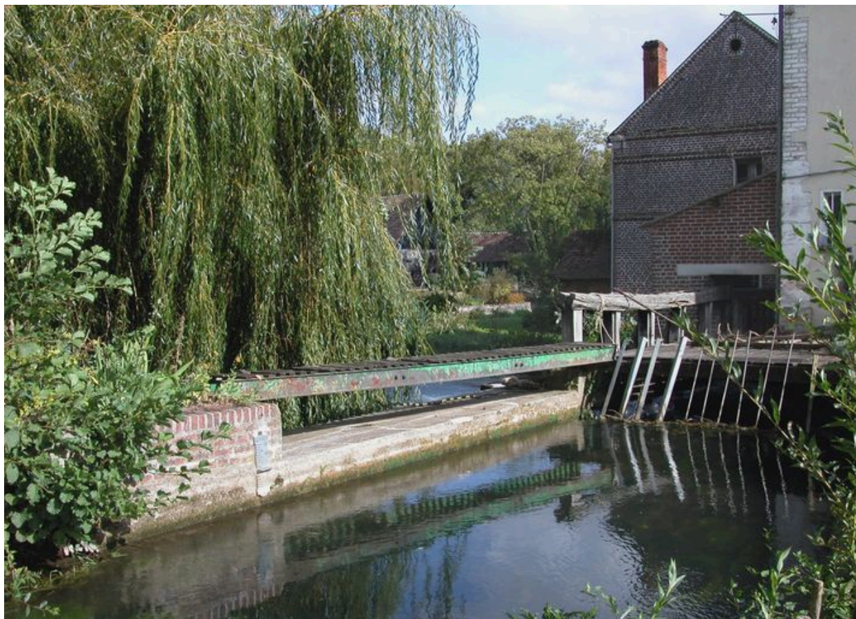
Le déversoir et le vannage de décharge.
