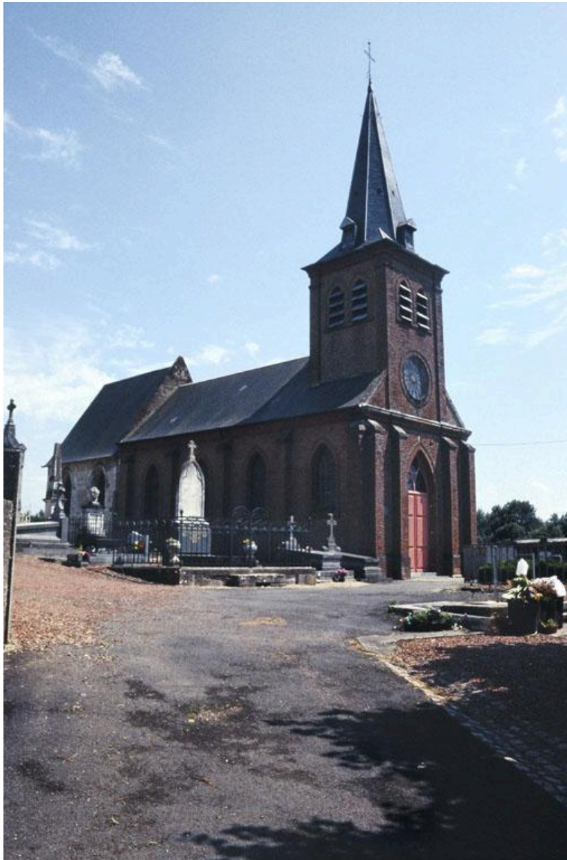
Vue de la façade occidentale et du flanc nord.
