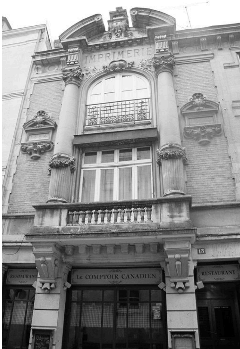
Façade sur rue : détail.
