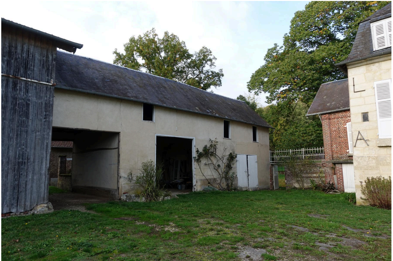
Vue générale des bâtiments situés côté est (passage charretier et local de service).
