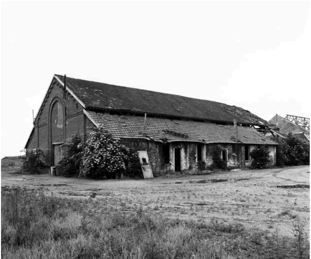
Entrepôt industriel sud pour le stockage des betteraves : façade nord.
