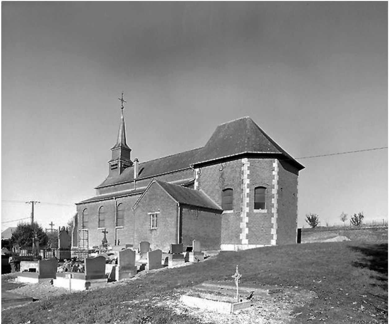
Vue depuis le sud-est.
