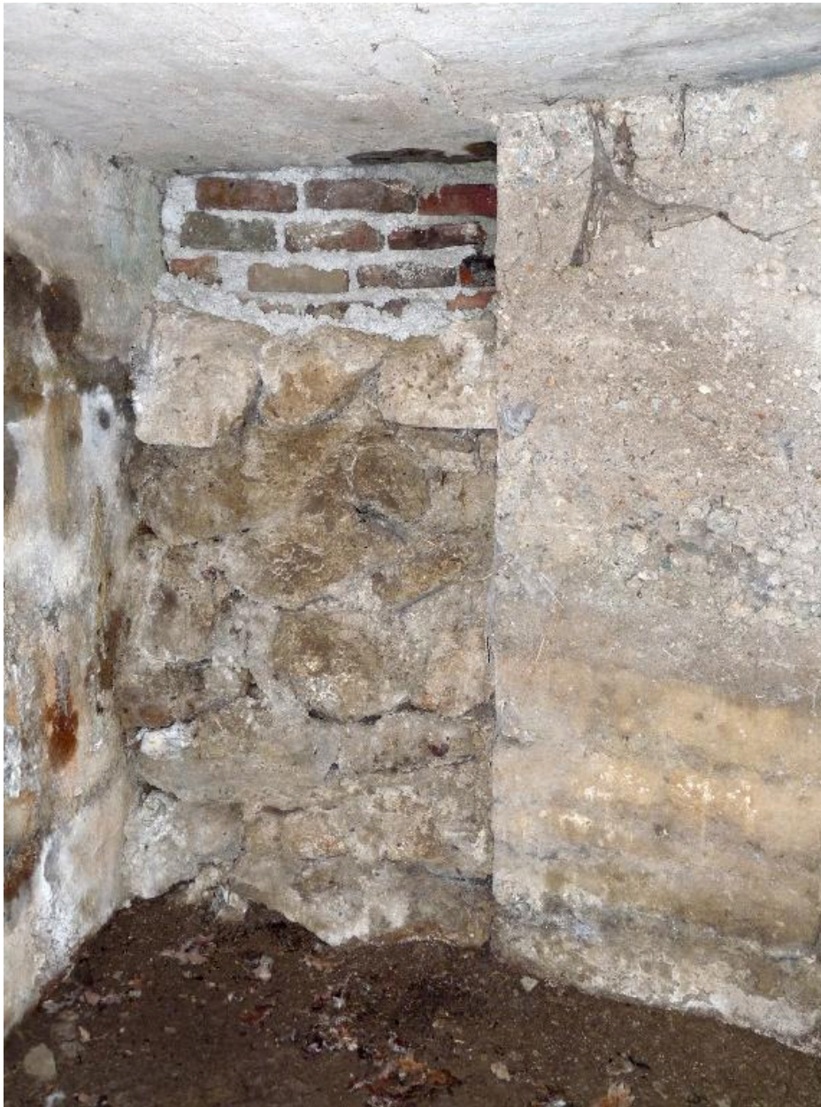
Extrémité ouest du couloir
