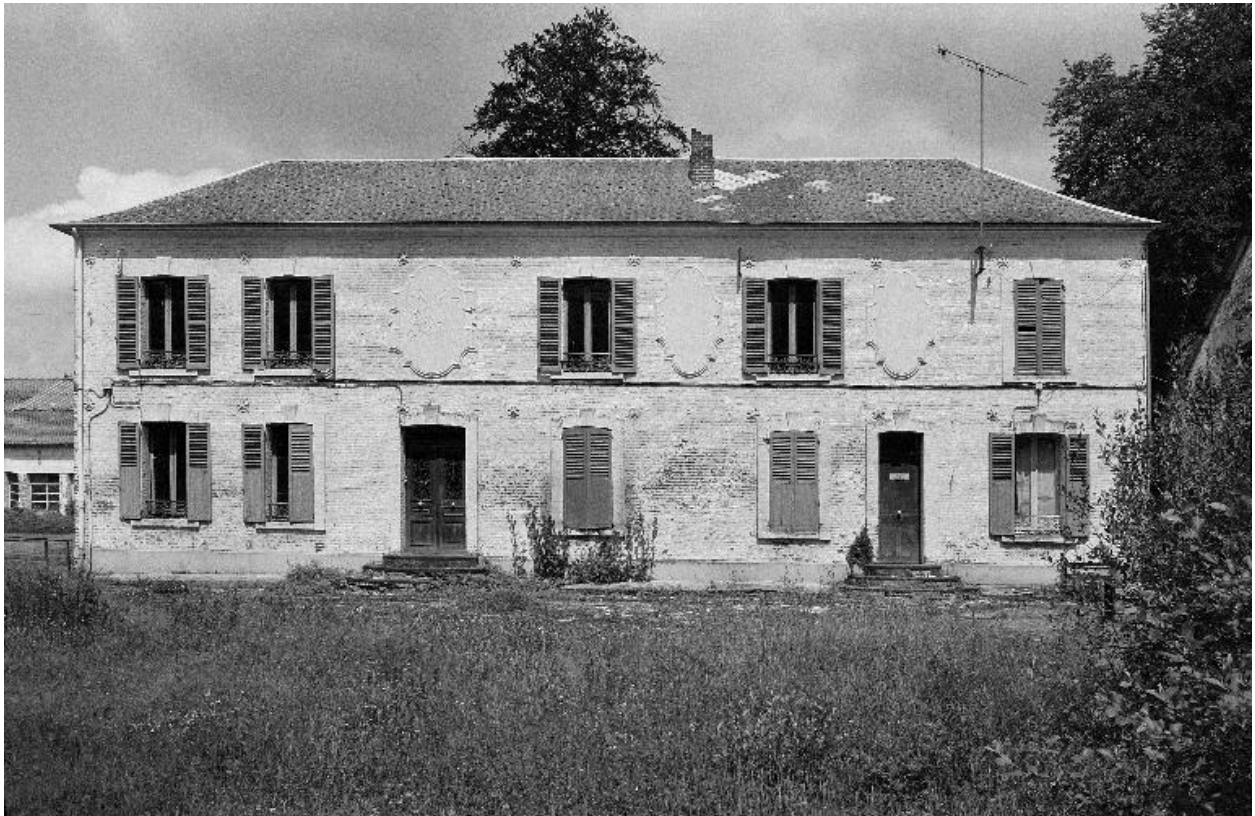
Bureaux, élévation sud.
