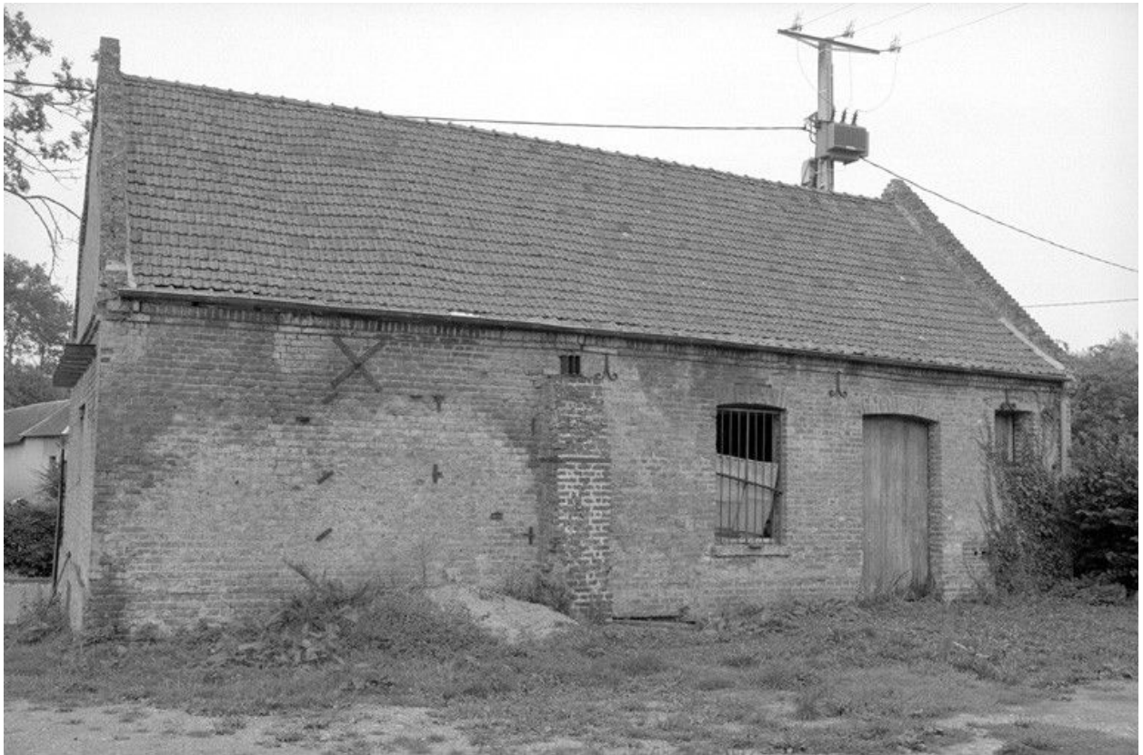
Remise, élévation postérieure.
