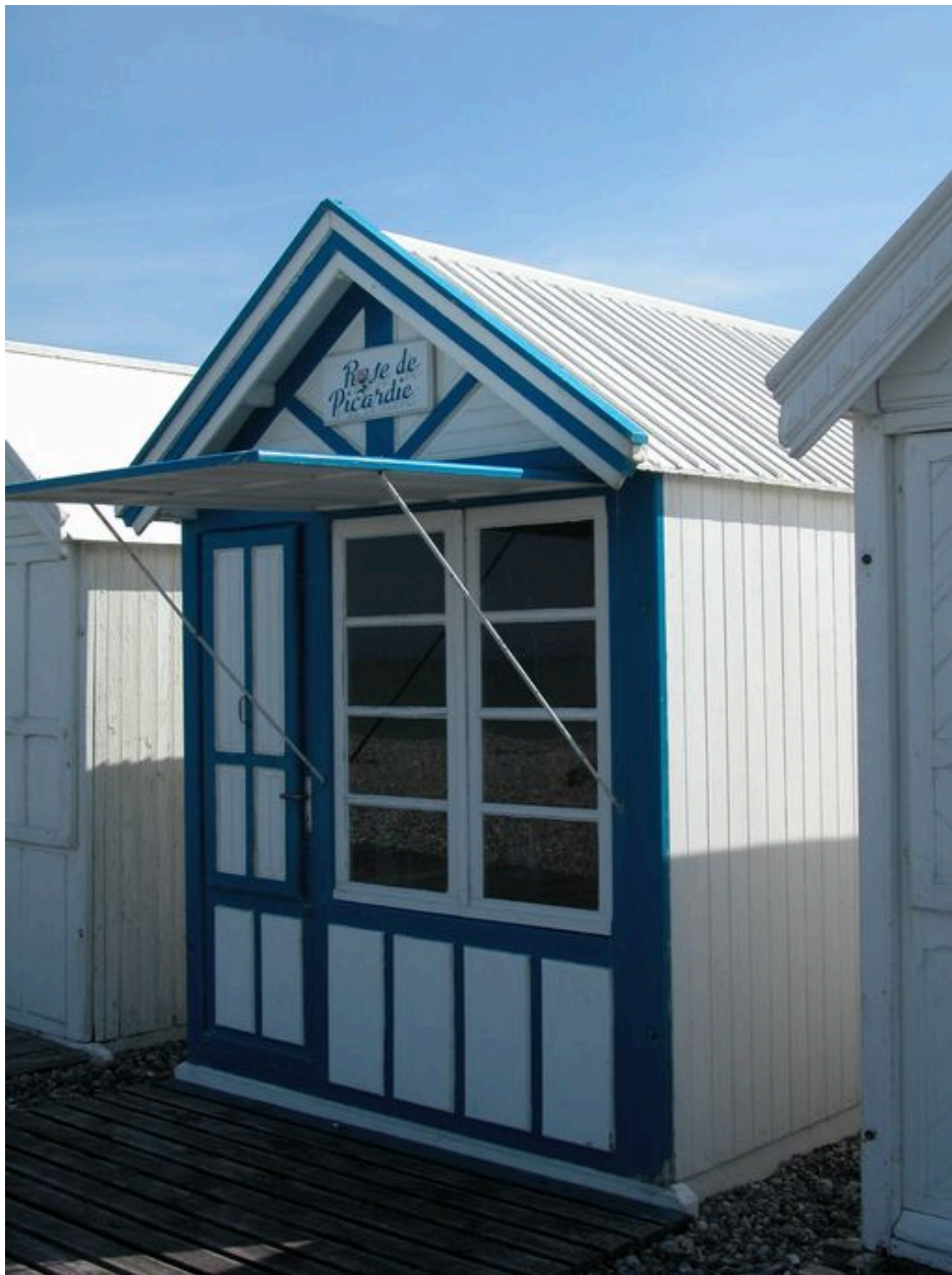
Détail d'une cabine ouverte.
