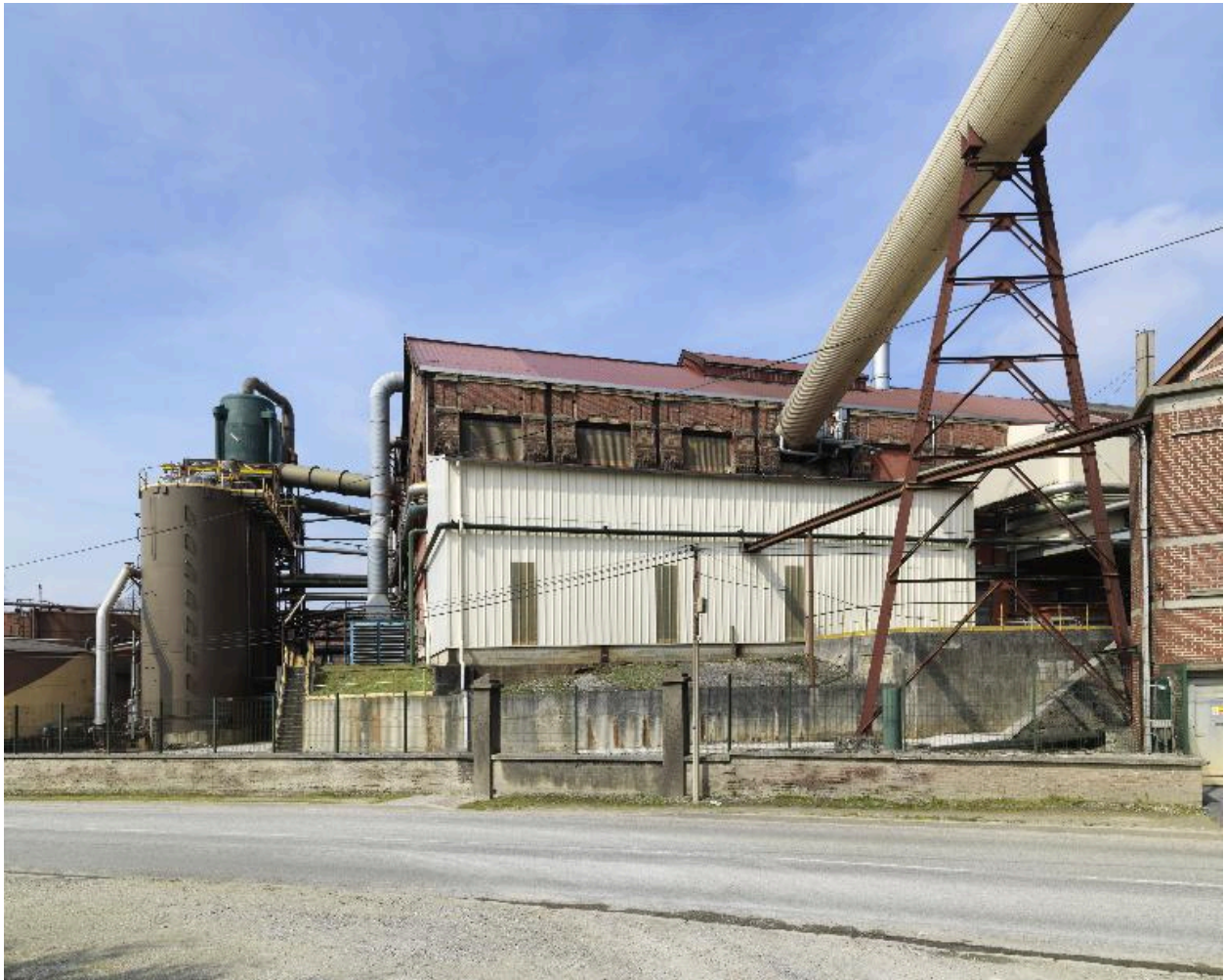
Mur ouest de l'atelier de fabrication principal de la sucrierie.
